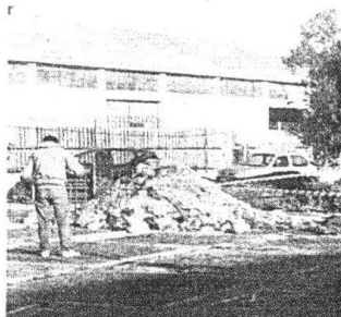
L'area interessata dai lavori
